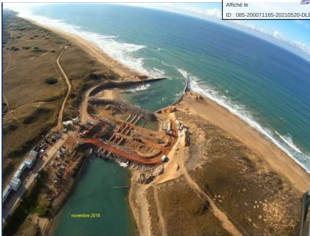
Annexe 6 : Restauration du perré et de la risberme du remblai des Sables d'Olonne (promenade Clémenceau), juillet 2020
