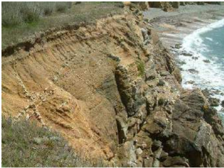
Exemple d'érosion localisée sur la côte rocheuse
