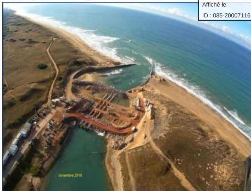
Annexe 7 : Ecluse de la Gachère en cours de restauration
