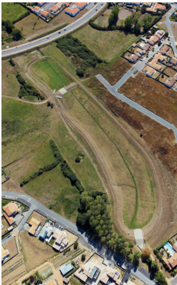
Vue aérienne du bassin de la Gobinière au Château-d'Olonne. Quatre autres bassins sont répartis sur toute l'agglomération.
