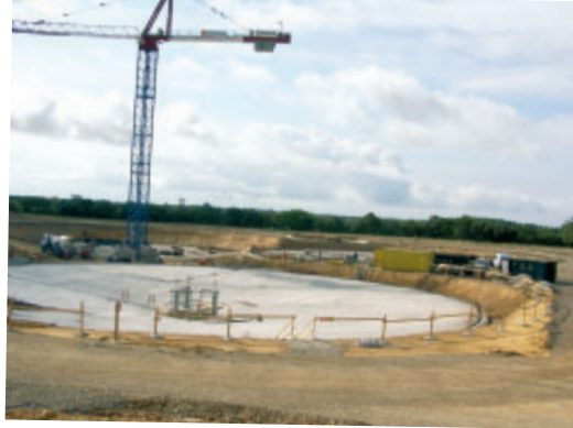
JUIN 2006 DÉBUT DU TERRASSEMENT
