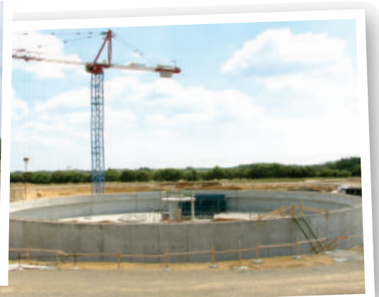
AOÛT 2006 LES MURS SORTENT DE TERRE
