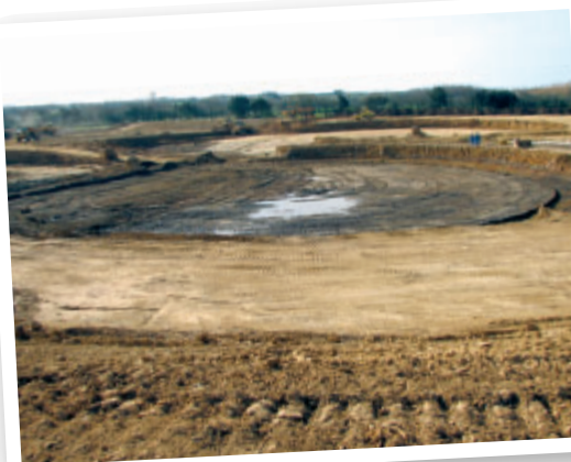
AVRIL 2006 LES FONDATIONS
