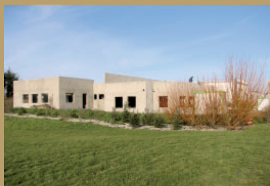
Décembre : les murs sont sortis de terre
