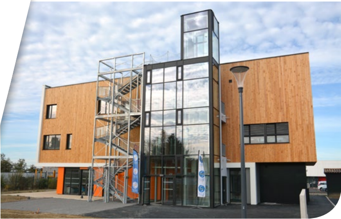
L'isolation par l'extérieur a permis d'éviter l'installation d'une climatisation dans les locaux.
