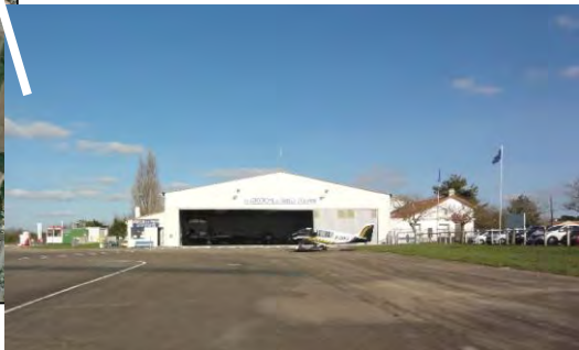
Hangar utilisé par l'aéroclub de la Vendée
